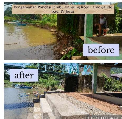
Gambar 3 Pengaman pondasi jembatan
