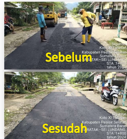
Gambar 1 Pekerjaan Patching AC WC
