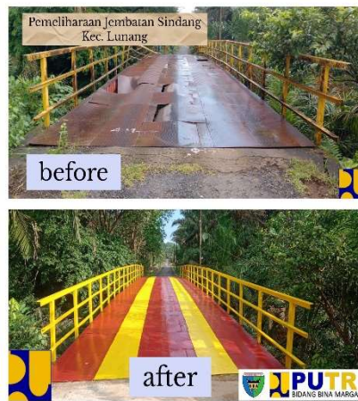
Gambar 4 Penggantian lantai dan pengecatan
